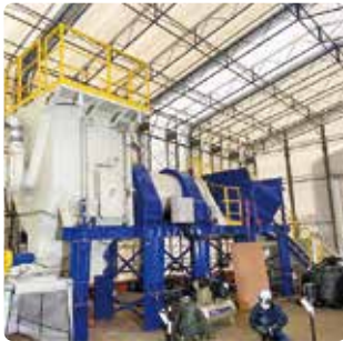
福島県内での試験の様子(開発技術の一部)
